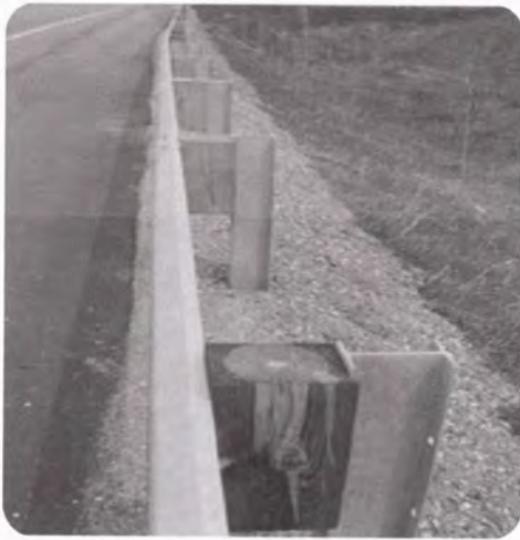
รูปที่ ๖ การติดตั้งราวกันอันตรายแบบรวมเหล็กผูกบนเสาแข็งข้างทางและเกาะกลาง
