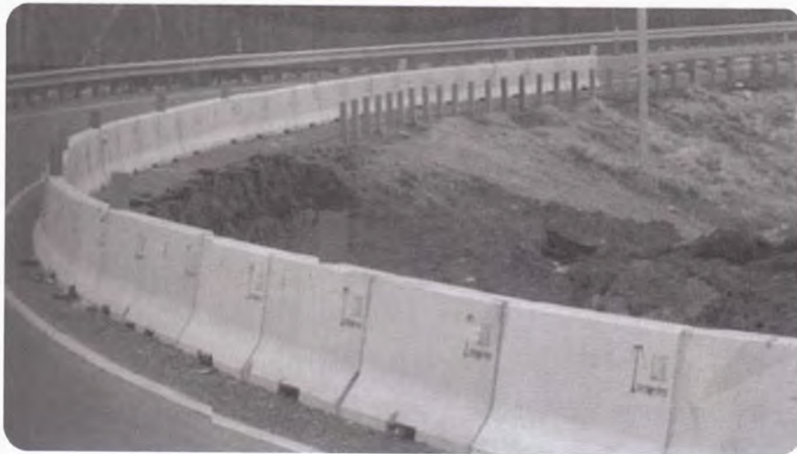
รูปที่ ๗ การติดตั้งราวกันอันตรายแบบคอนกรีต
