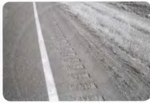
รูปที่ ๒๕ ตัวอย่างการติดตั้งแถบชะลอความเร็วข้างทางที่ระยะไม่เพียงพอ สำหรับรถจักรยาน/จักรยานยนต์
