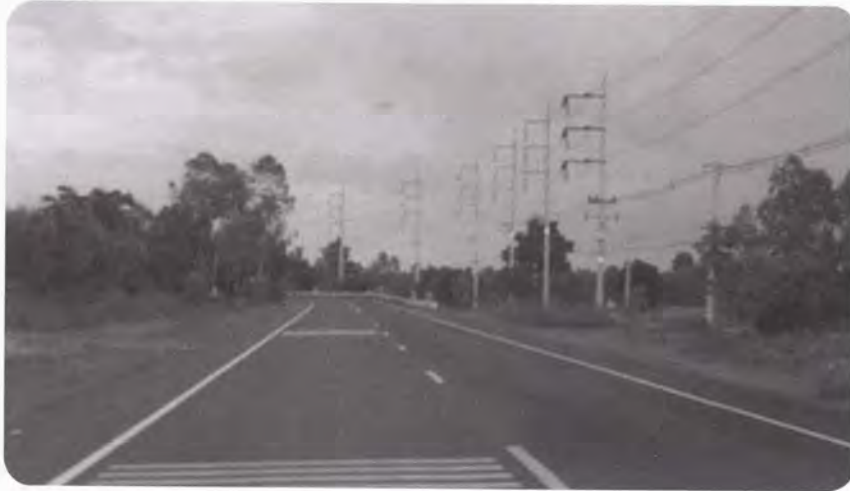
รูปที่ ๑๓ ระบบการยับยั้ง (Traffic Calming) แบบแถบชะลอความเร็ว
