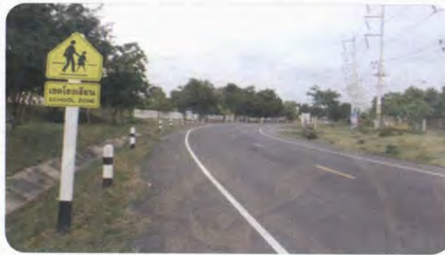
รูปที่ ๒๗ หลักนำทางแบบคอนกรีตบนถนนสองช่องทาง
