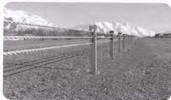
รูปที่ ๓ การติดตั้งราวกันอันตรายแบบเคเบิลข้างทาง
