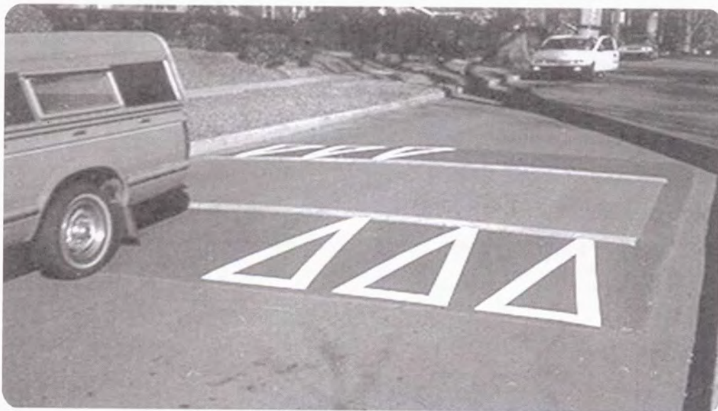
รูปที่ ๑๖ เนินชะลอความเร็วแบบโค้งพาราโบลา Flat-topped หรือ Speed Table
